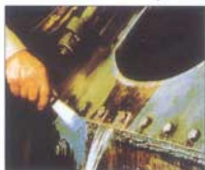
Composto epossidico unico, anticorrosione, altamente esotermico per la riparazione, sigillatura e ricostruzione di equipaggiamenti in ambienti costantemente bagnati, persino sott'acqua. Aderisce in modo sicuro anche in presenza di acqua ad acciaio, ferro, alluminio, ottone, bronzo, cemento, legno e alcune plastiche. Utilissimo in applicazioni marine, piattaforme e impianti trattamento acqua, ma anche nell'industria del legno e della carta.
