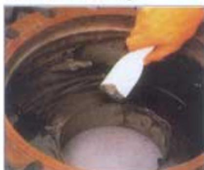
Poliuretano pastoso facile da miscelare, 100% solido, ideale per numerose applicazioni di rivestimento e protezione. Indurisce in una gamma resiliente di media durezza. Aderisce in modo sicuro alla maggior parte dei materiali. Resiste all'abrasione asciutta fino a 82°C e bagnata fino a 49°C.
