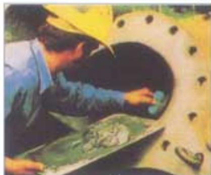
Composto epossidico caricato acciaio inossidabile per sigillatura anticorrosiva, riparazione e ricostruzione di equipaggiamenti in acciaio inox. Aderisce ai metalli ferrosi e non. Indurisce a temperatura ambiente. Omologato FDA.
