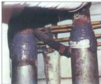
Resina epossidica rapida, caricata acciaio per riparazioni e manutenzioni di emergenza, durature e lavorabili con macchine utensili applicabile a bassa temperatura fino a 4°C. Protina per essere rimessa in servizio in meno di 1 ora. Aderisce ad acciaio, ferro, alluminio, ottone e cemento.
